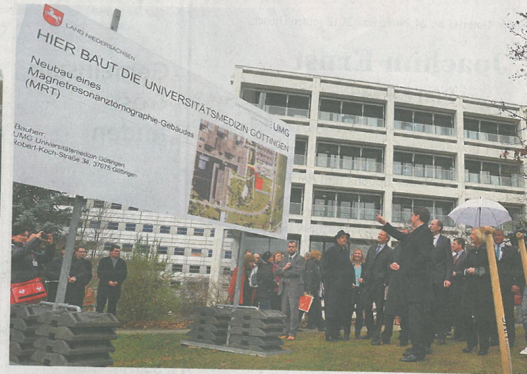
Ostseite des Klinikums: Dort liegt der Bauplatz für das neue Herzforschungs-MRT.
